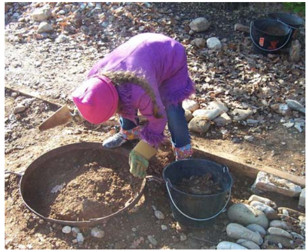
Réalisation du chemin en pierre sèche
